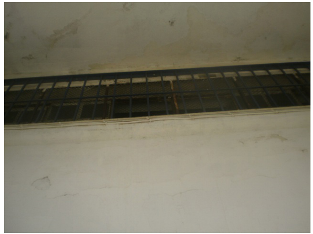
Εικόνα 41: το εσωτερικό του στρατοπέδου κράτησης των Βρυσιών Έβρου όπου τα κάγκελα είναι τοποθετημένα εσωτερικά. Ο ίδιο ισχύει στο Αλλοδαπών της Π.Ράλλη.
