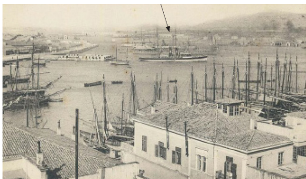
Εικόνες 23, 24: Η 2η θέση του λοιμοκαθαρτηρίου Πειραιά στον Άγιο Νικόλαο, στη θέση του σημερινού κτιρίου του Ο.Λ.Π.
